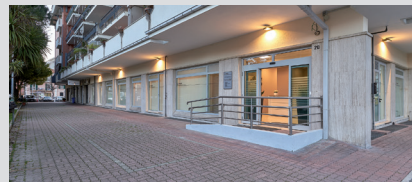
Locali climatizzati - Parcheggio privato
